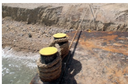
Zone snapback : en cas de rupture d’un câble, la digue amortit le coup.
