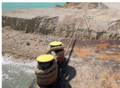
Zona de snapback: caso um cabo venha a romper-se, o dique de areia absorverá o impacto.
