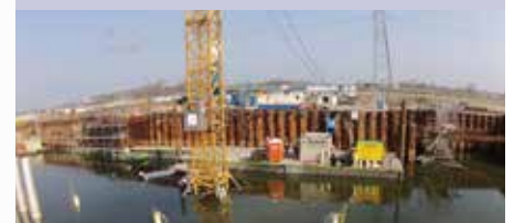
| Vista Geral do aqueduto em Muiden
