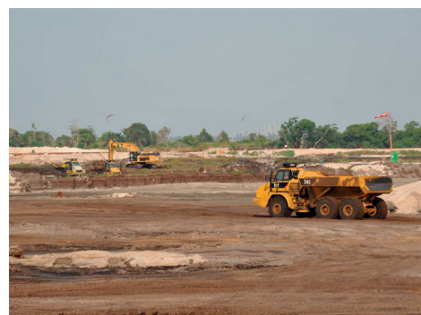
Werkzaamheden in Gabon
