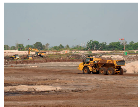
Kaivutöiden yhteydessä Gabonissa
