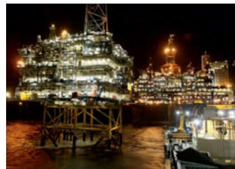
Rockpiper au travail à la plate-forme Sleipner
