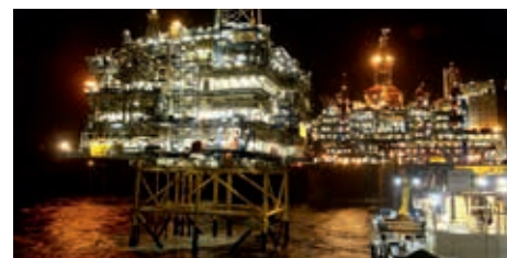
Rockpiper trabalhando na plataforma Sleipner
