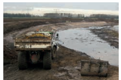
Getrap talud bij de Bevert kreek, Noordwaard polder
