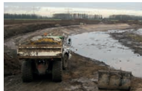
Porrastettu rinne Bevertin kaivuukuopalla, Noordwaard-polderilla
