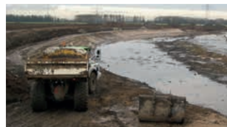
Accotement en gradins près du chenal de Bevert, polder de Noordwaard
