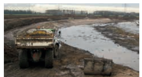
Talud escalonado junto a Bevert Kreek, en el pólder Noordwaard
