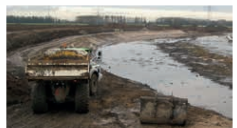
Talude escalonado no Bevert Kreek, polder de Noordwaard
