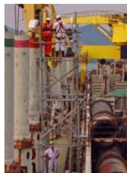
*La seguridad es lo más importante: también para trabajos sencillos, como la inspección de un sensor sobre un cilindro de la compuerta inferior, se monta un andamio.*
