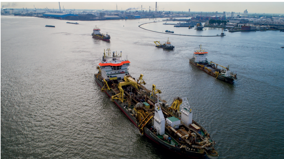
| Sleephopperzuigers Prins der Nederlanden, Strandway en Causeway op het project Verdieping Nieuwe Waterweg & Botlek
