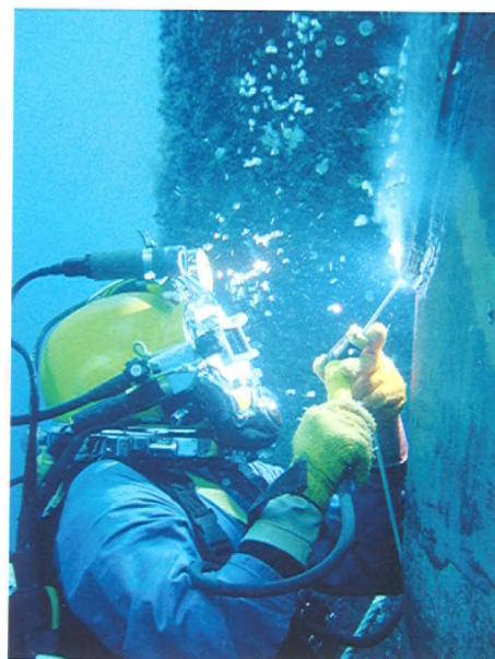
Een duiker voert reparatiewerkzaamheden uit aan een platform.
