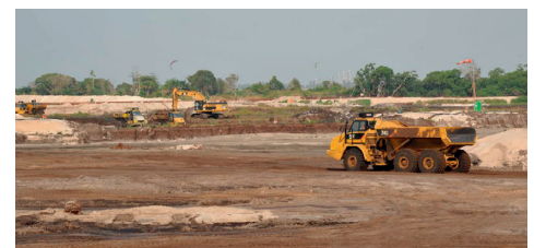
Ausschachtungsarbeiten in Gabon
