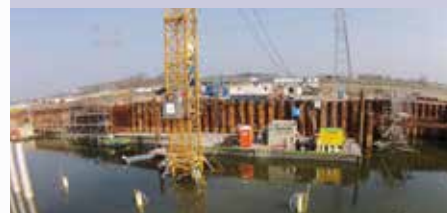
| Vue de l’aqueduc inondé à Muiden
