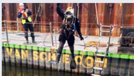
| Plongeur travaillant à Muiden
