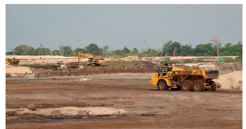
Escavação no Gabão
