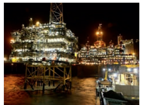
Rockpiper aan het werk bij het Sleipner platform
