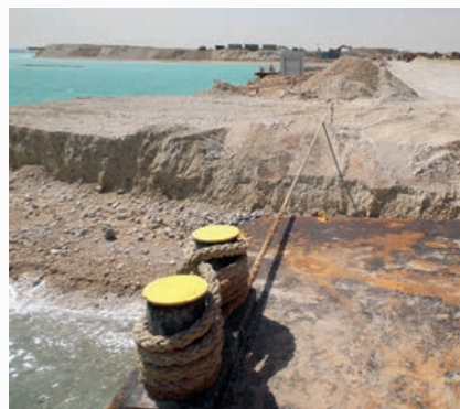
↳ Snapback zone: mocht een draad onverhoopt knappen, dan vangt de zanddijk de klap op.
