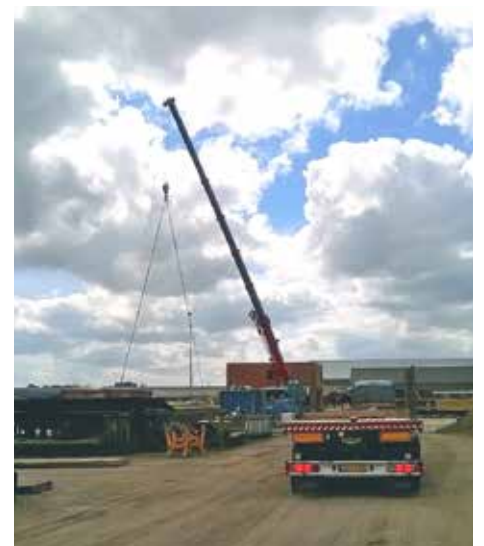
| Dredgināg, obras Middenmeer, proyecto IJsei, Países Bajos
