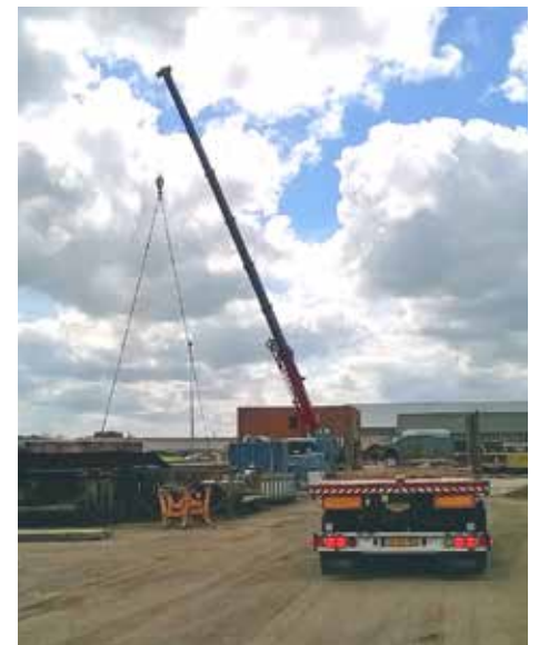
| Dragage, Travaux à Middenmeer, projet IJSei, Pays-Bas.
