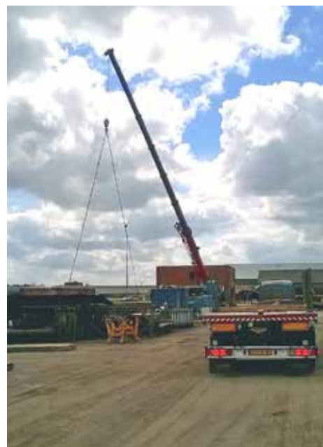
| Dredging, Werkzaamheden Middenmeer, project IJsei, Nederland
