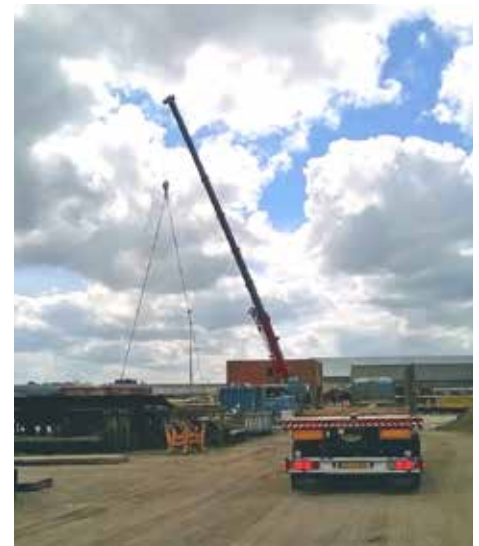
| Baggerarbeiten in Middenmeer, Projekt IJsei, Niederlande.
